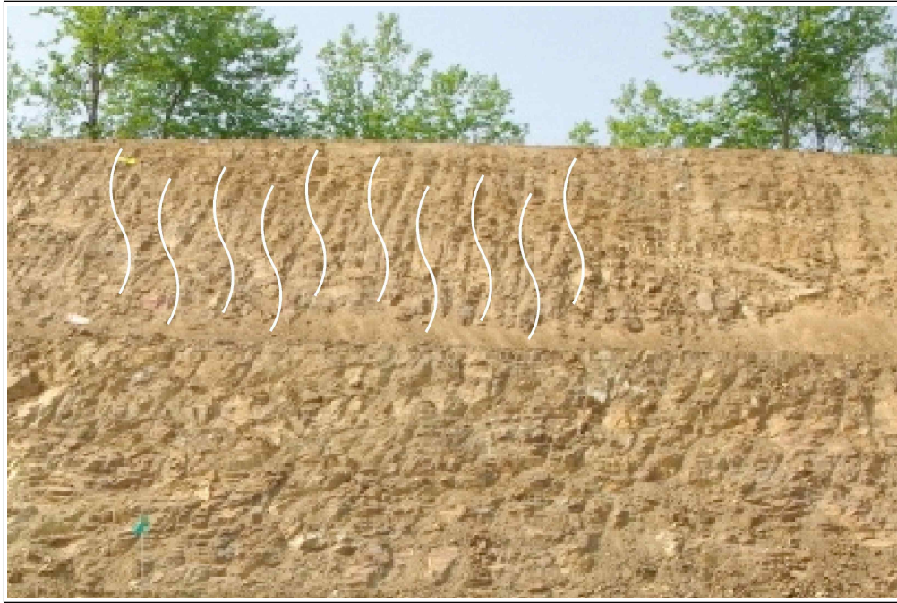
【그림 20】 C 영역 상세사진 (토사유실 및 우류침식)
