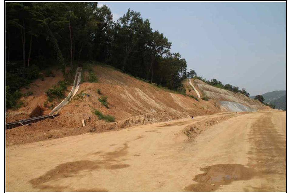
【그림 4】 깎기비탈면 종점부 측면 사진
