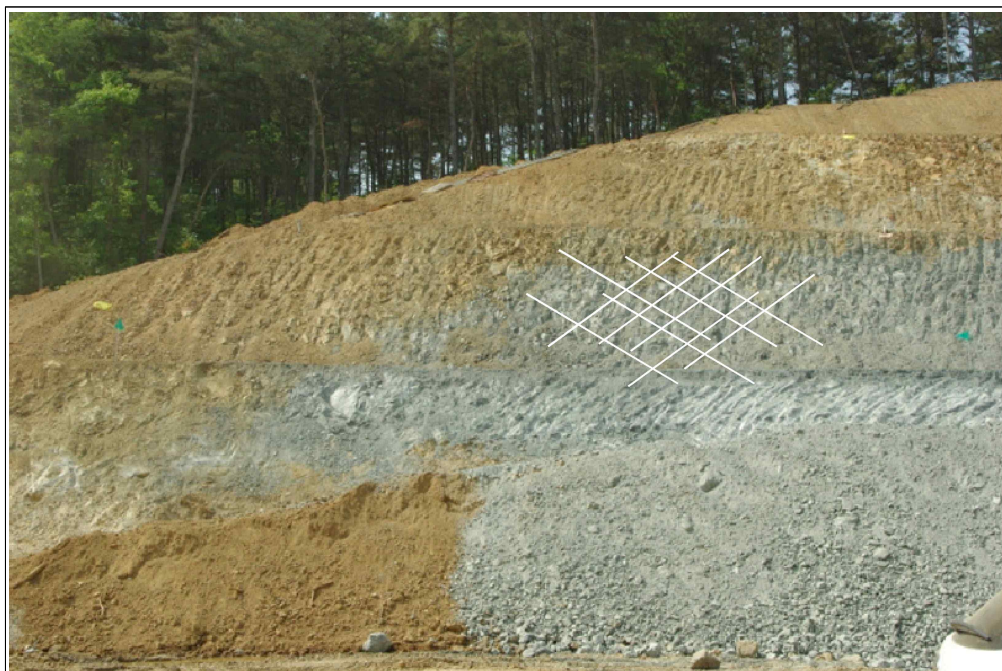
【그림 16】 B 영역 상세사진 (세편화된 암석)
