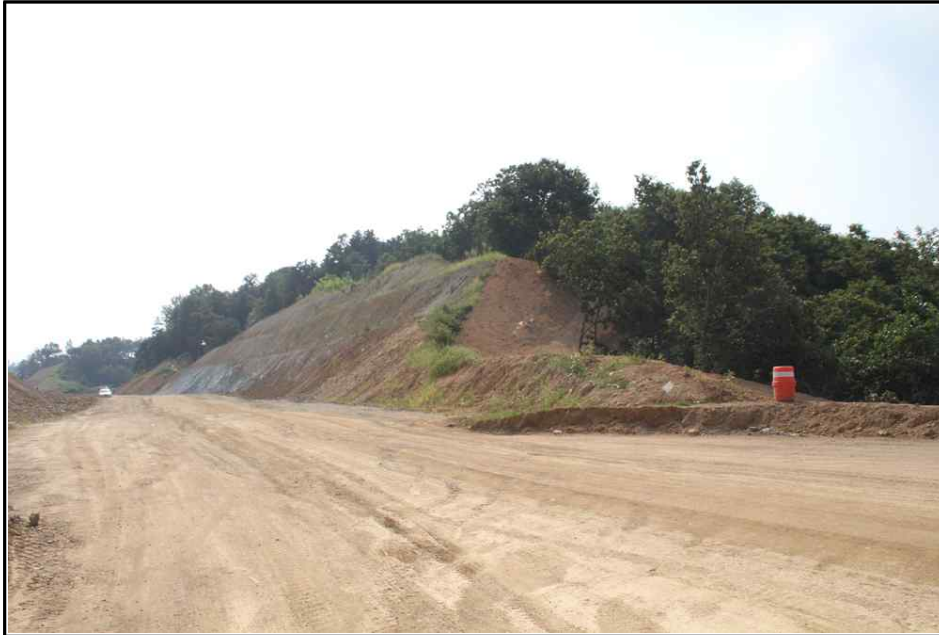
【그림 3】 깎기비탈면 시점부 측면 사진
